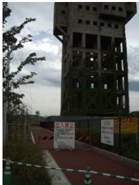
立坑橋の真下「ロード建設
