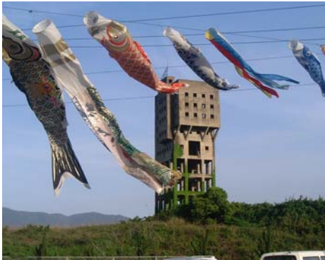
高さ 53.63mの「立坑櫓」
