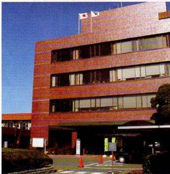
57年に建てた庁舎
