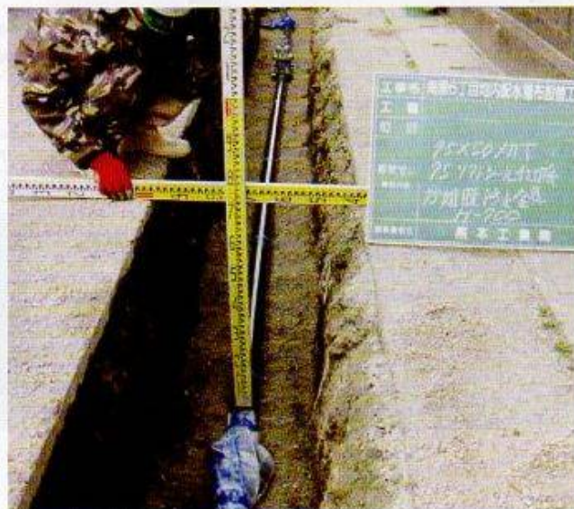
水道管の設置工事
