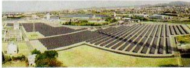
▲メガソーラー大牟田発電所全景
