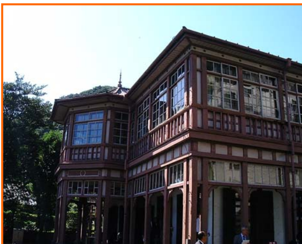
写真…旧鹿児島紡績所技師館
